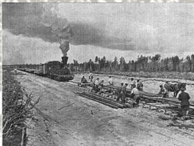
Строительство Транссибирской железной дороги
